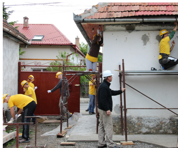
Acțiune de voluntariat cu „Habitat for Humanity”
