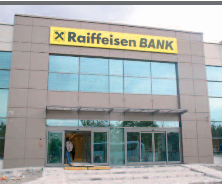
Centrul Operațional Pipera
